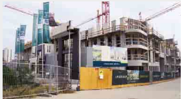
Blick auf die entstehenden Pariser Höfe
