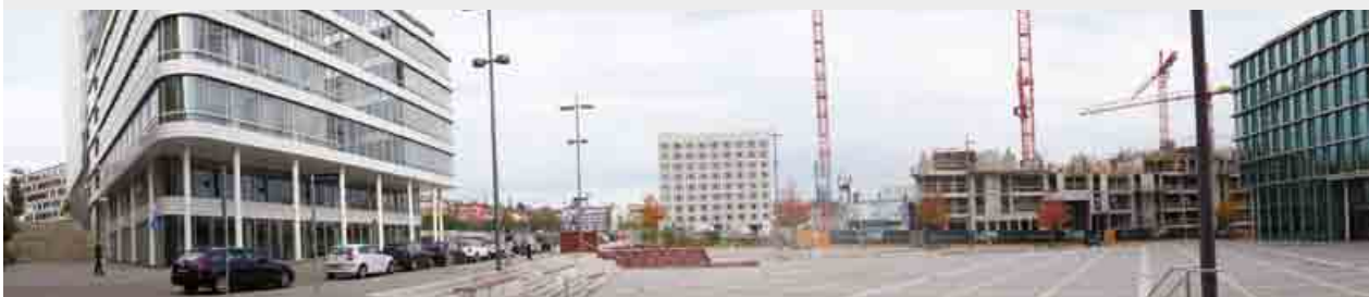
Panoramablick über den Pariser Platz mit den LBBW-Gebäuden im Westen und Osten, der neuen Bibliothek am Mailänder Platz und den im Bau befindlichen Pariser Höfen im Norden des Platzes
